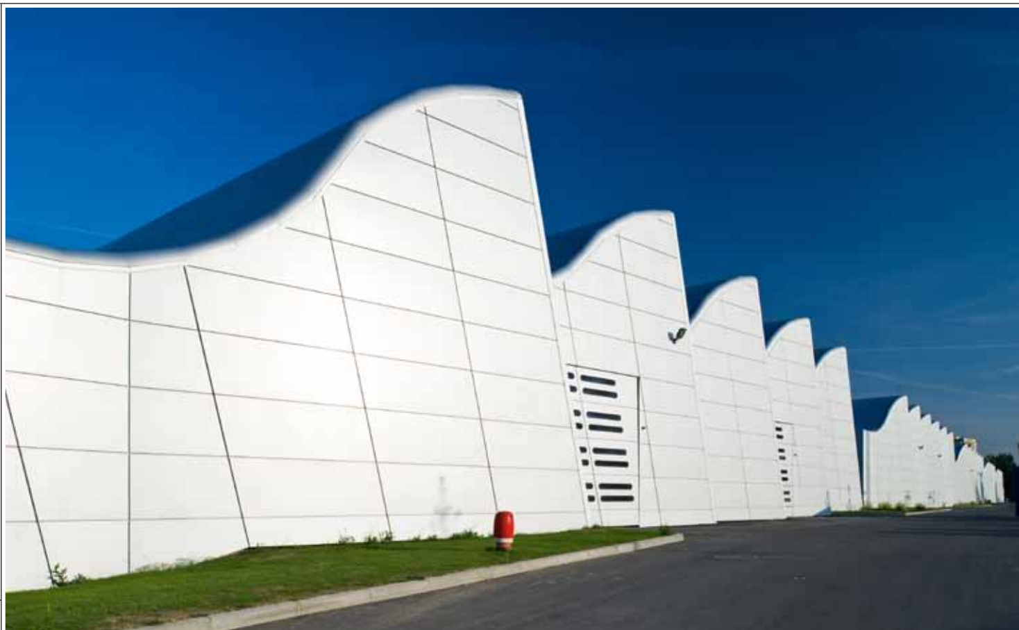
De gevels van de ateliers zijn opgebouwd uit cassettes in Aluzinc® Florelis (ArcelorMittal)._Façades des ateliers, sous forme de cassettes réalisées en Aluzinc® Florelis (ArcelorMittal).
