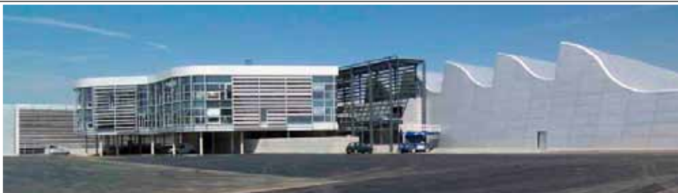
Totaalzicht van het Gallieni-lyceum in Toulouse (FR). _Vue d'ensemble du Lycée Gallieni, Toulouse (FR).
