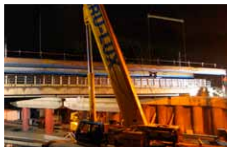
Plaatsing van liggers voor het overschrijden van de 'Collectrice' aan de Moulin de Bascharage, lijn Luxemburg-Athus, 2005 _Pose des poutrelles pour franchissement de la Collectrice au Moulin de Bascharage, Ligne Luxemburg-Athus, 2005
