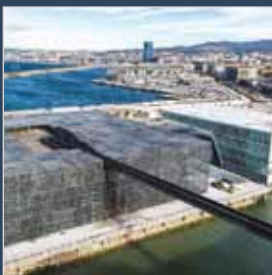
SICA an Assystem Company Cat. 1 Gebouwen / Bâtiments
