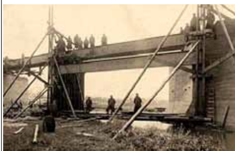
Plaatsing van liggers boven de Alzette in Fentange, lijn Luxemburg-Bettembourg, 1917 (bron www.rail.lu ) _Pose des poutrelles pour franchissement de l'Alzette a Fentange, Ligne Luxemburg- Bettembourg, 1917 (source www.rail.lu )
